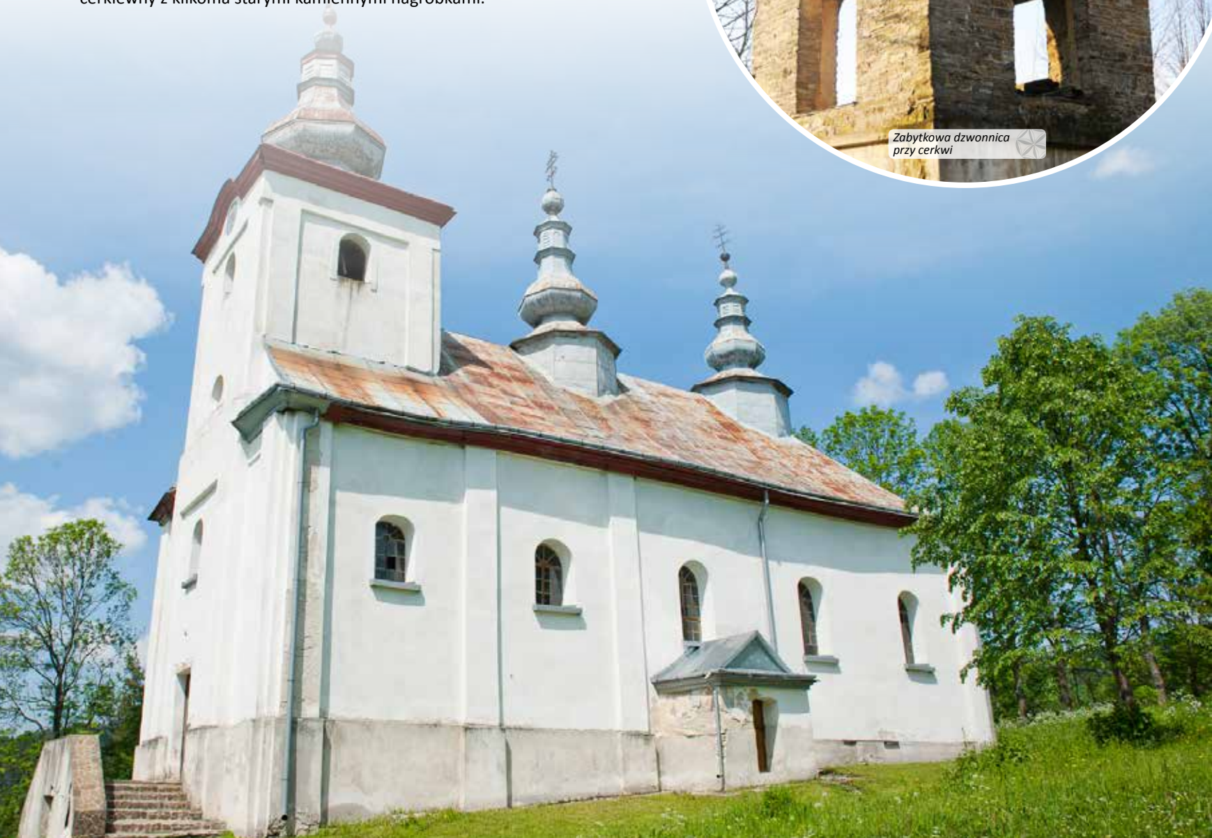
Cerkiew pw. Przeniesienia Relikwii św. Mikołaja w Smolniku nad Ostawą
